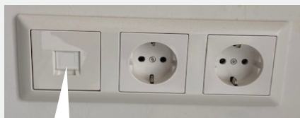
RJ45/UTP-aansluiting in woonkamer en (grote) slaapkamer
