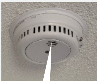
Lipje montage- plaat rookmelder
