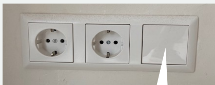
Lege doos achter deze deksel (met trekdraad naar meterkast) voor extra UTP-aansluiting in de woonkamer en (kleine) slaapkamer
